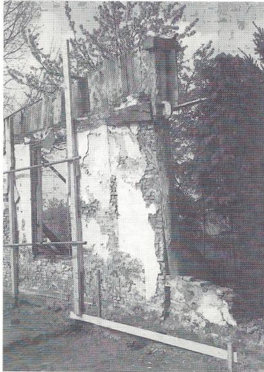
Detail nog aanwezige gebintpoot gelijk enige Rijksmonumenten in Bronkhorst. Hier eens de invulling van laat leemwerk op riet. Dit is in de 19e eeuw vervangen voor een pakweg 75 cm wand van staande delen hout, hierover is riet aangebracht en dit is aangesmeerd. Deze unieke situatie blijft behouden.
