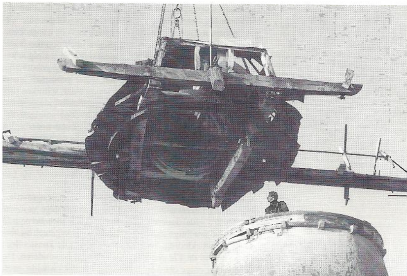
De kap, met ruim 8 ton roestend ijzer en kachelhout gaat van de romp...
