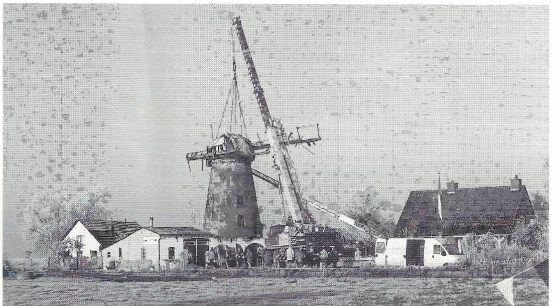
De gammele kap hangend in de hijsbanden nog op de molenromp...
