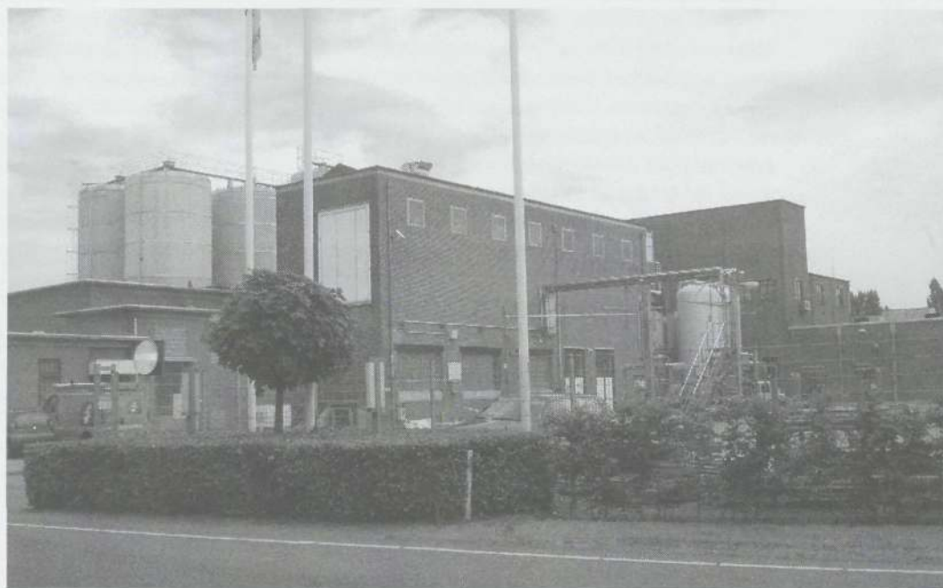
De Zuivelfabriek in Steenderen
